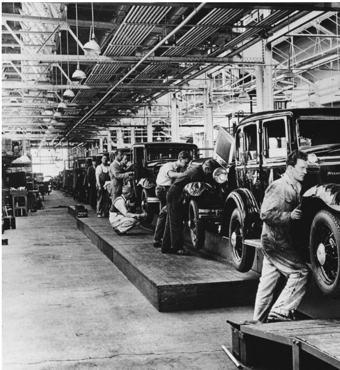
Smede samler Ford biler på samlebånd i 1930'erne på Ford Motors samlefabrik i Sydhavnen. Foto: Arbejdermuseet & ABA.
