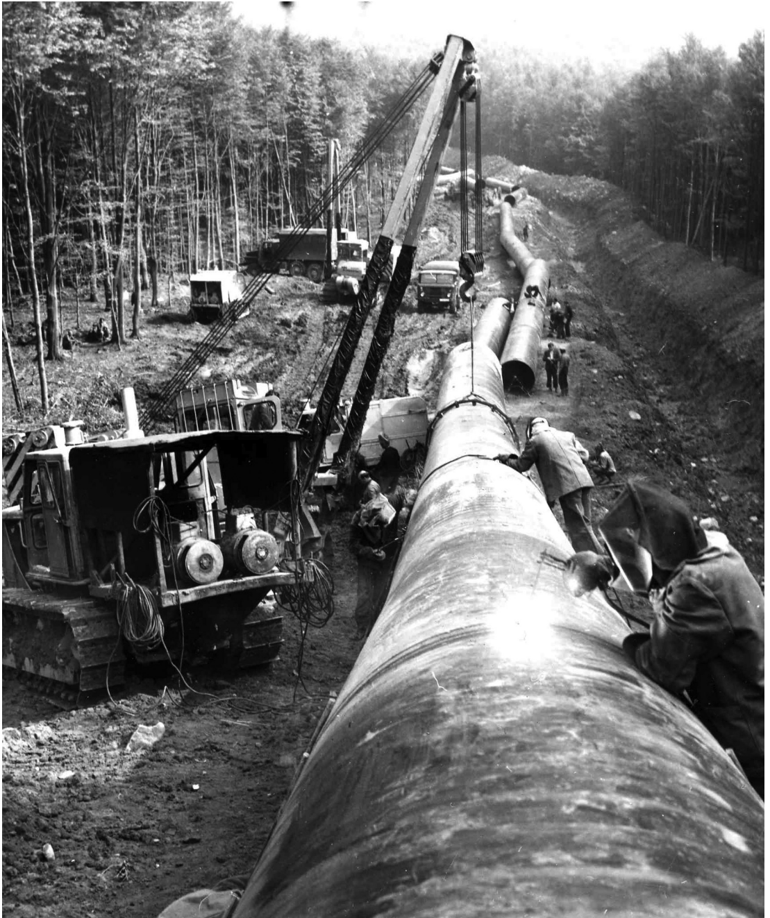
Bygning af gasrørledning i Sovjet i 1982. Rørledningen skal bringe gas fra Sibirien til Vesteuropa. (Foto: Arbejdermuseet & ABA)
