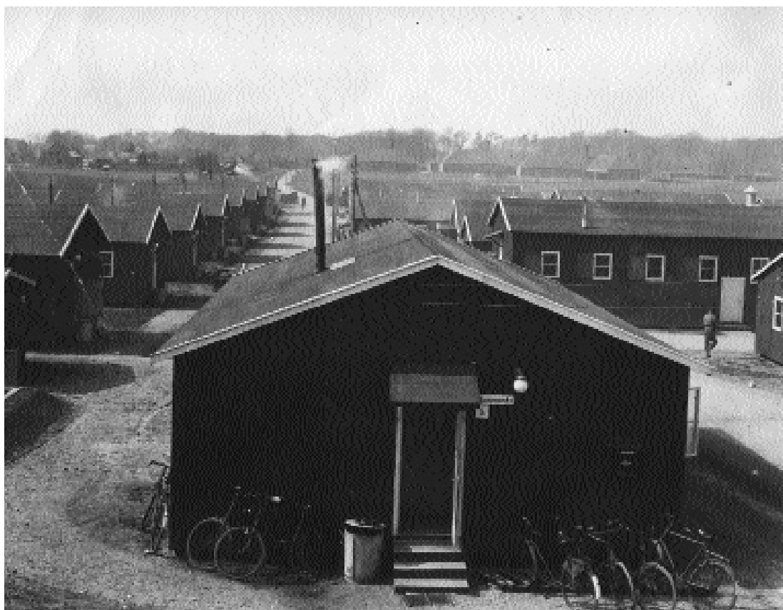
Barakkerne i Jægersprislejren, hvor skolens elever var indkvarteret under deres ophold på Modstandsbevægelsens Befalingskole.
