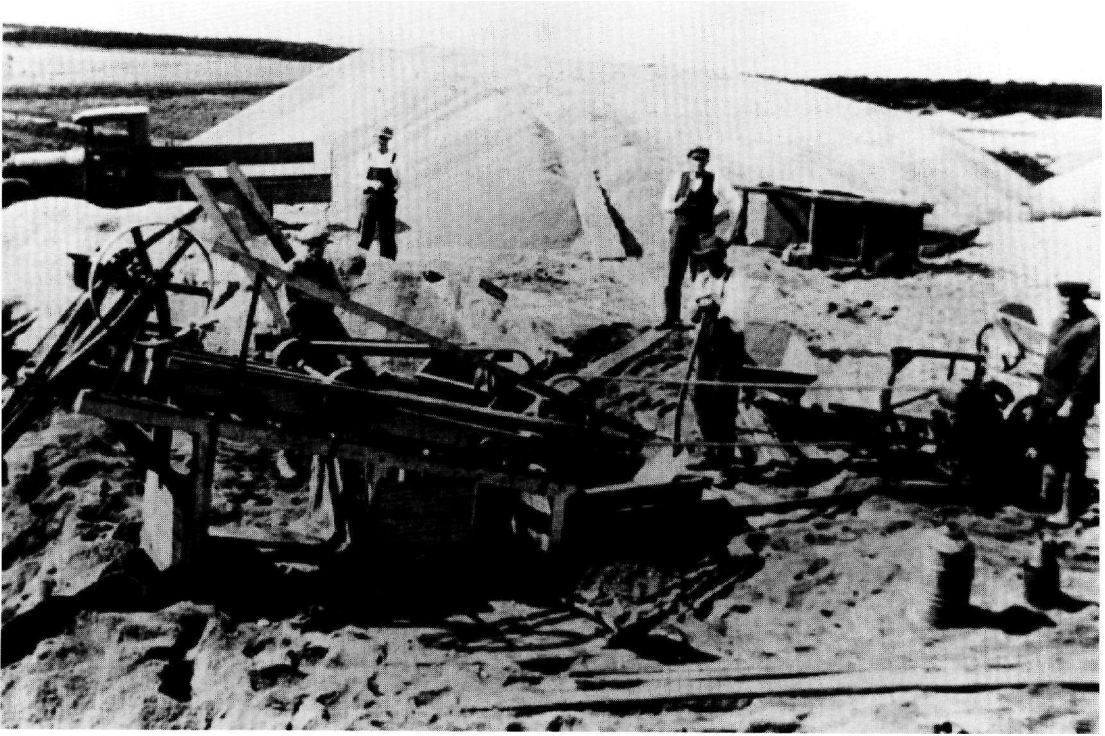
Ralgravning til befæstningsbyggeriet ved Oksbøl ca. 1943. (Blåvandshuk Egnshistoriske Arkiv)
