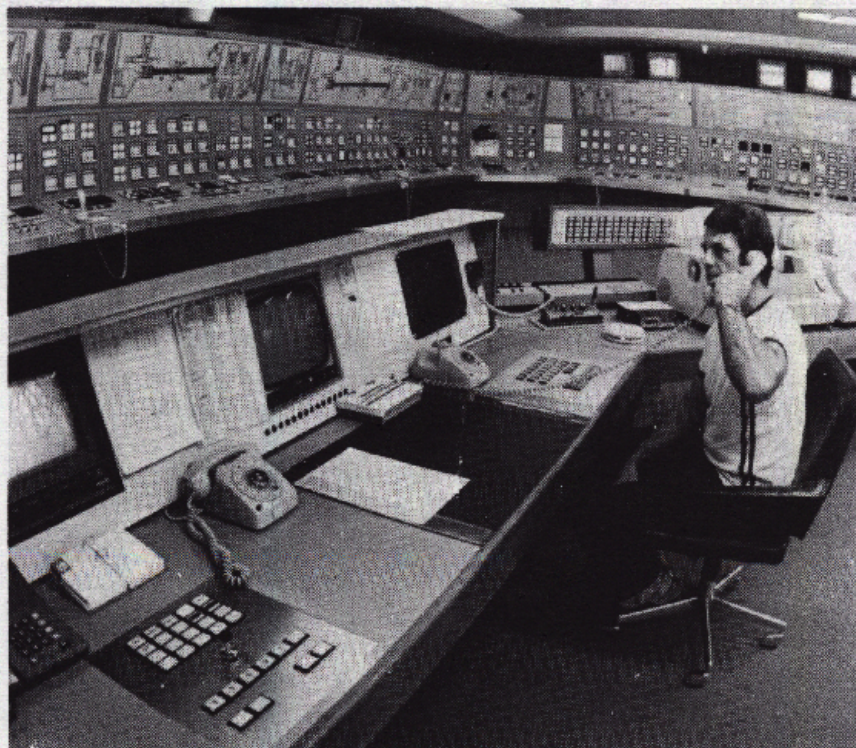
Dette er også en cementarbejder. Kontrolrummet på Aalborg Portland Cementfabrik ca. 1975.
