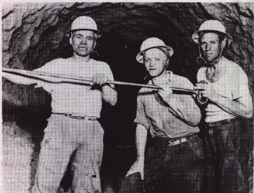
Cementarbejdere på Rørdal Cementfabrik ca. 1935. Arbejde i ovnen (Aalborg lokalhistoriske arkiv).
