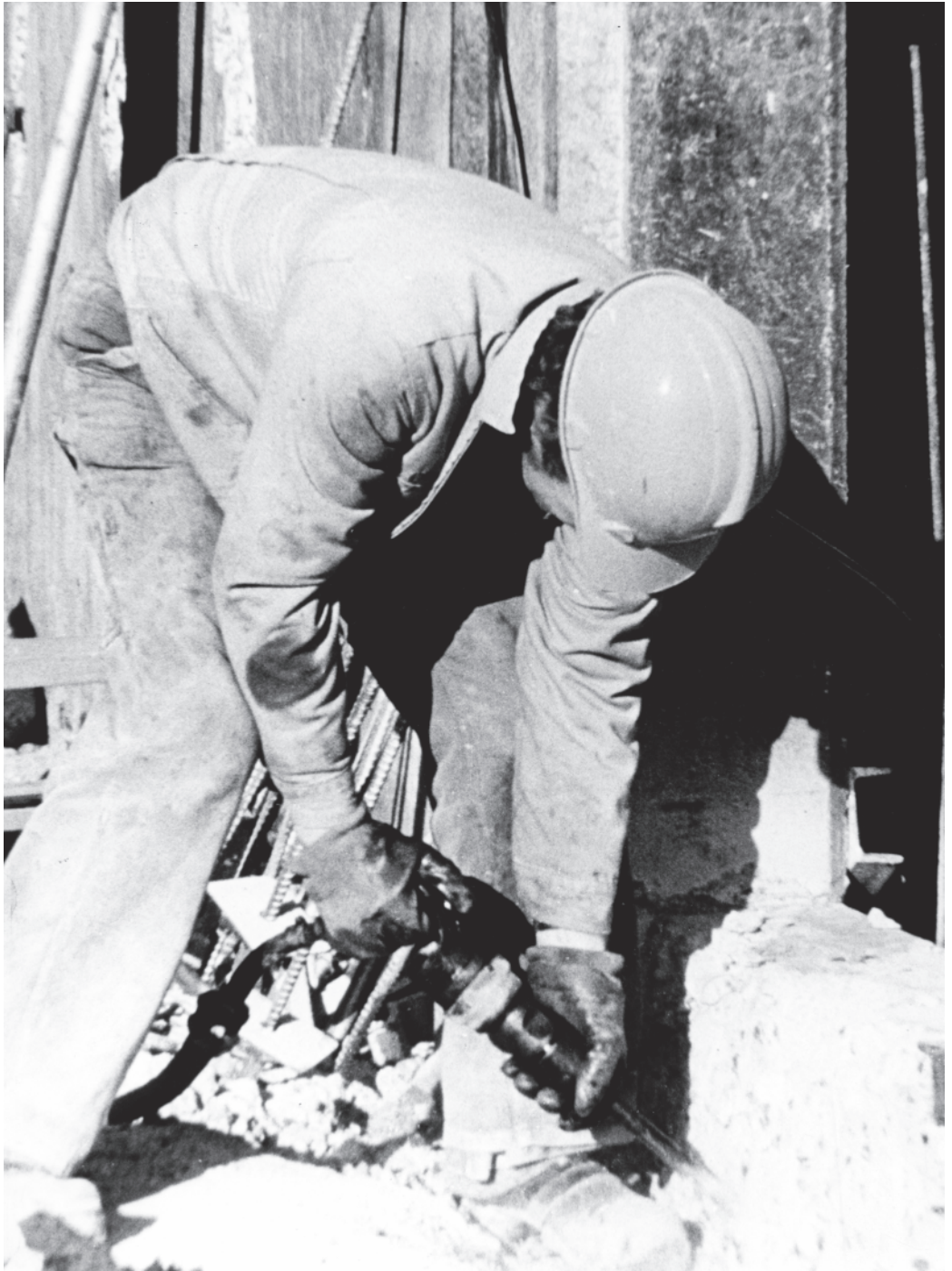
En rigtig jord-og beton arbejder arbejder med en lille luft hammer, 1984. (Foto: Arbejdermuseet & ABA)
